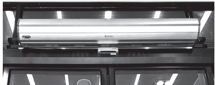
出入口の真上に設置されたエアーカーテン
