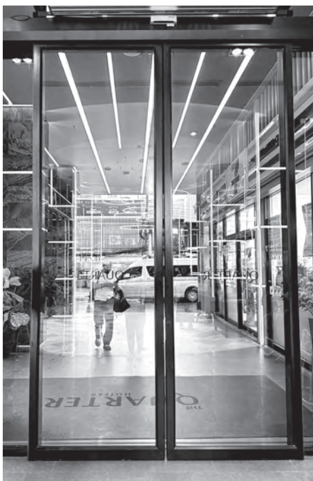
出入口の真上に設置されたエアーカーテン
